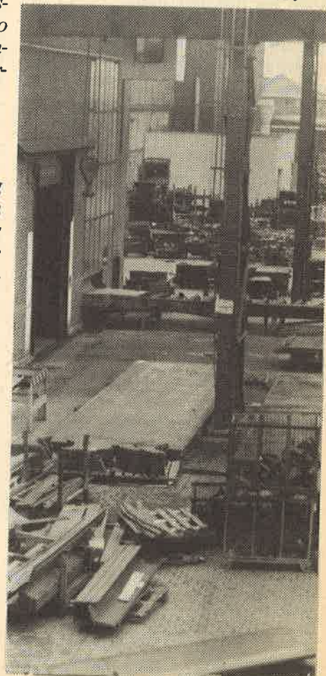
Hanomag wird demontiert
